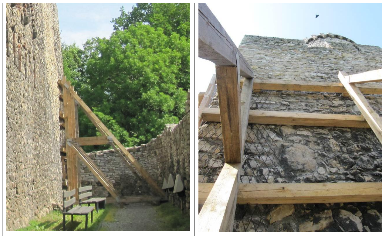
Rys. 25. Podstemplowany zagrożony fragment muru zamku w Będzinie; 2011 r.
