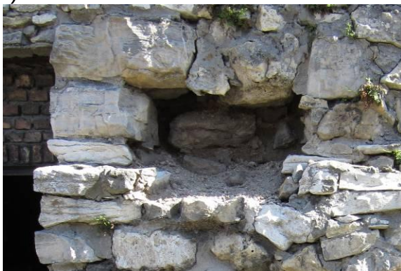
Rys. 6. Struktura muru typu „opus emplectum” widoczna w istniejących odkrywkach
