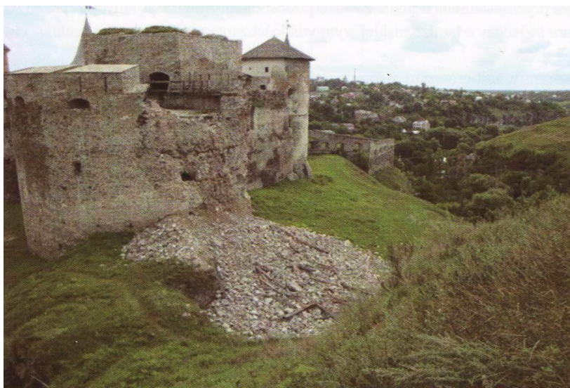
Rys. 17. Katastrofa kamiennego muru starego zamku w Kamieńcu Podolskim [2.15], 2011 r.
